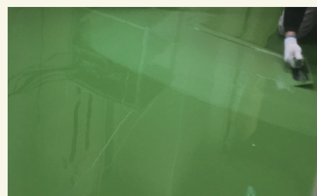
カット目地が不要なため、短工期で施工できる
